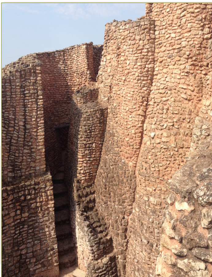
Detalle muros y torres del recinto fortificado. Motilla del Azuer (Daimiel, Ciudad Real). Fotografía: Miguel Torres Mas
